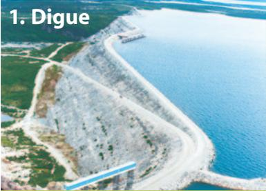
La digue QA-8 du réservoir La Grande 4, la plus imposante d'Hydro-Québec, s'étire sur 2 kilomètres et atteint 92 mètres de hauteur.
