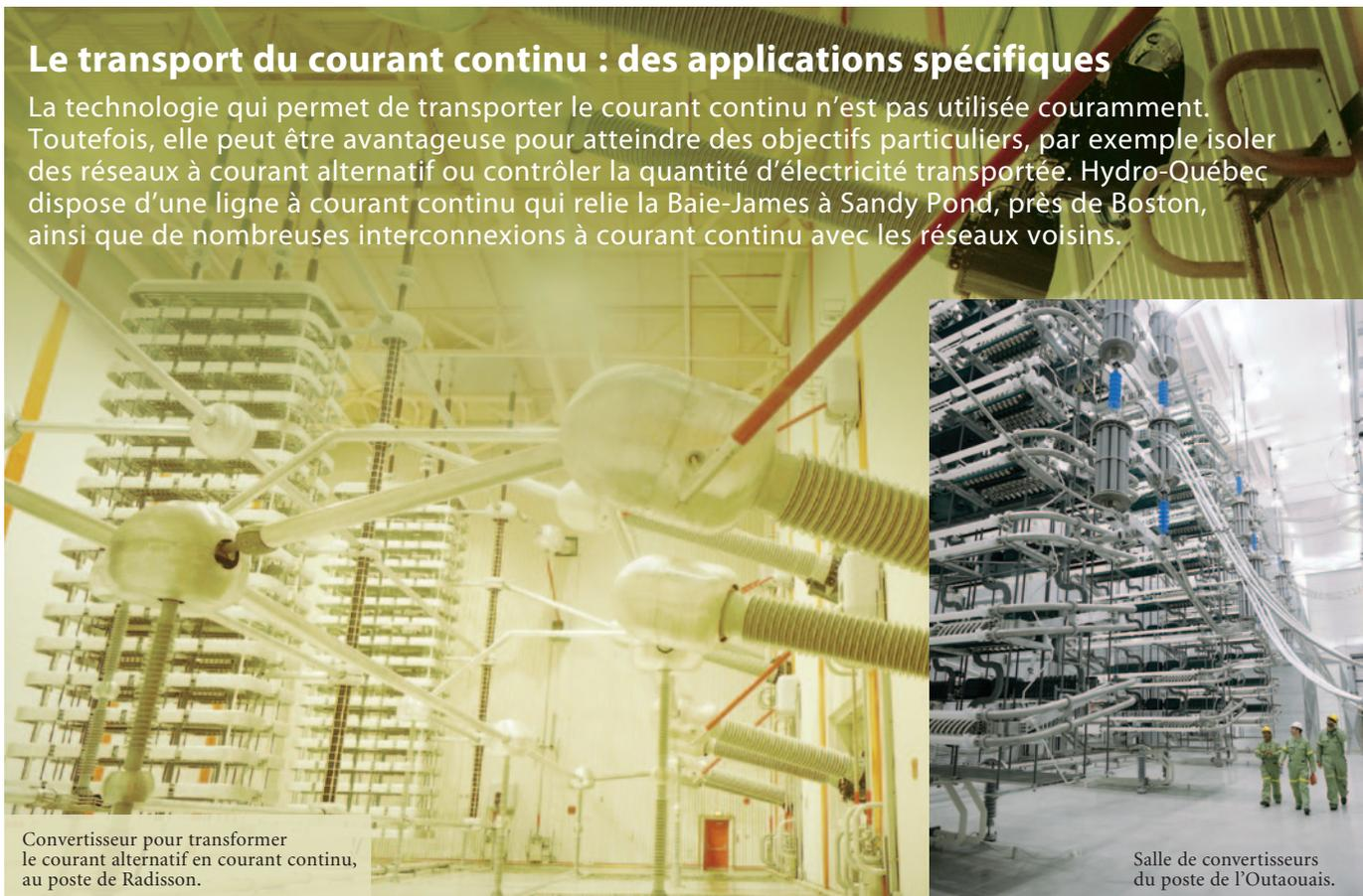
Convertisseur pour transformer le courant alternatif en courant continu, au poste de Radisson.
