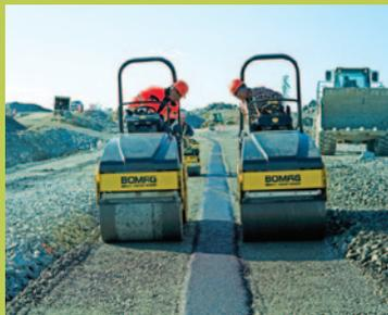
Construction d'un noyau en béton asphaltique pour le barrage de la Nemiscau-1. Bien connue en Europe, cette technique est utilisée pour assurer l'étanchéité d'un ouvrage en l'absence de moraine. Il ne manque pas de moraine dans la région de Nemiscau, mais Hydro-Québec veut s'approprier cette technique pour de futurs projets dans des régions nordiques, comme ceux de la Romaine, où la moraine est plus rare.
