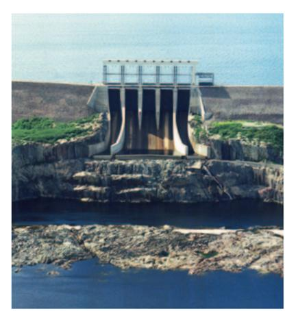
Sur les sites des centrales La Grande-3 et La Grande-4, les évacuateurs de crues ont une forme incurvée comme les tremplins pour sauts à ski. La courbe ascendante permet de projeter l'eau à des dizaines de mètres dans les airs, assez loin pour en réduire la force et éviter d'endommager le barrage.
