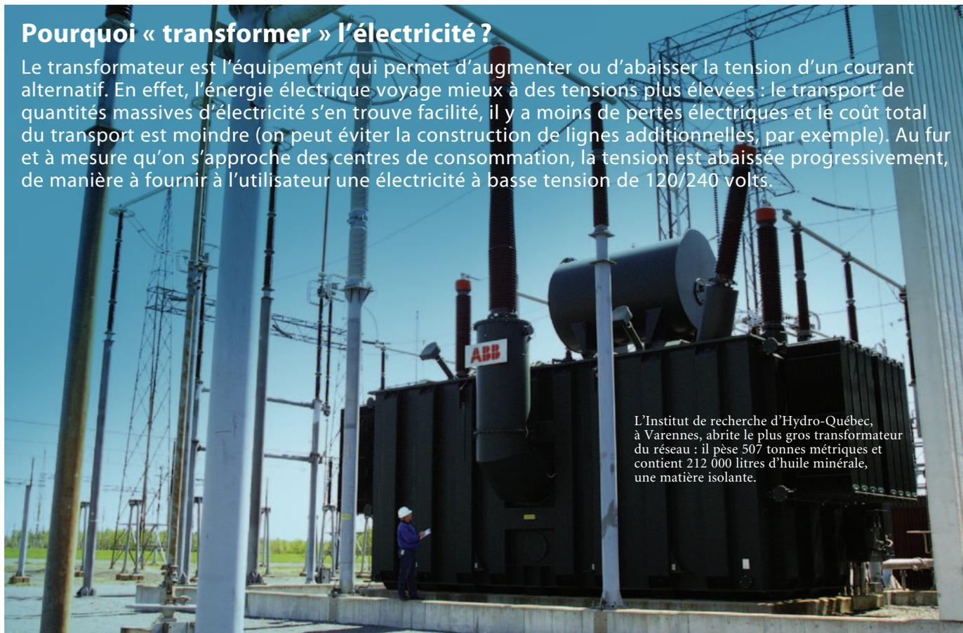
L'Institut de recherche d'Hydro-Québec, à Varennes, abrite le plus gros transformateur du réseau : il pèse 507 tonnes métriques et contient 212 000 litres d'huile minérale, une matière isolante.
